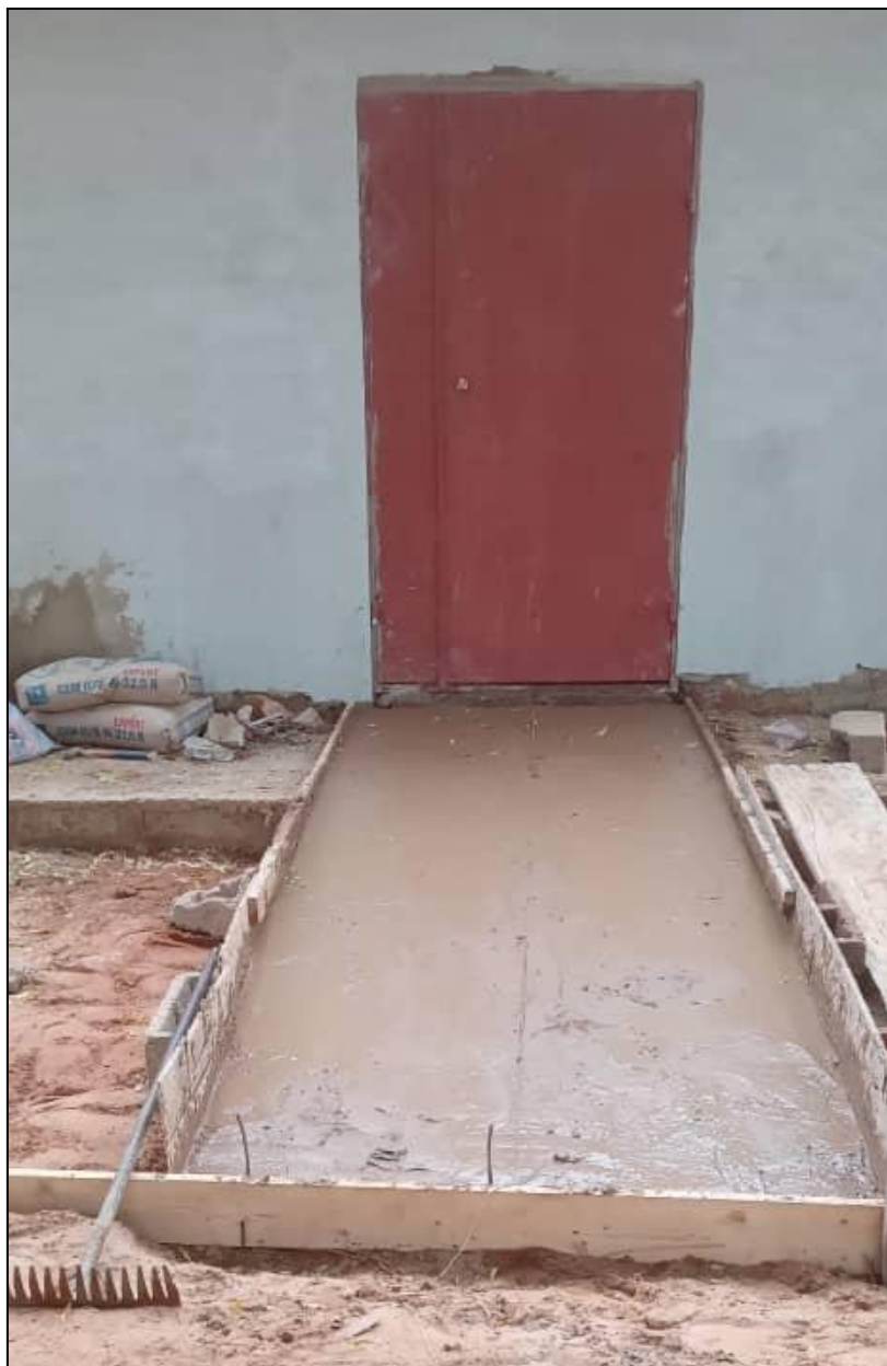
Obras de construcción de la cooperativa
