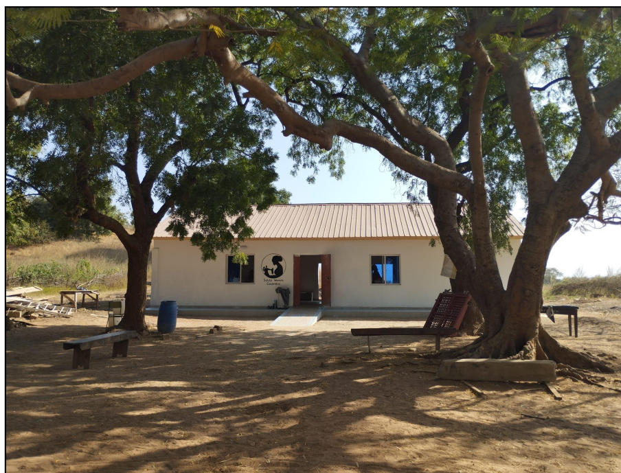
Después de la rehabilitación y construcción
