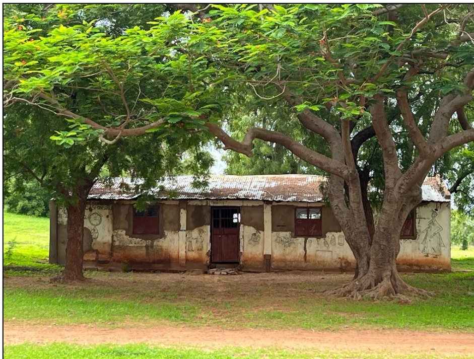
Antes de la rehabilitación y construcción
