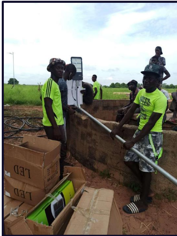
Ilustración 9. Jóvenes del pueblo instalando las farolas.
