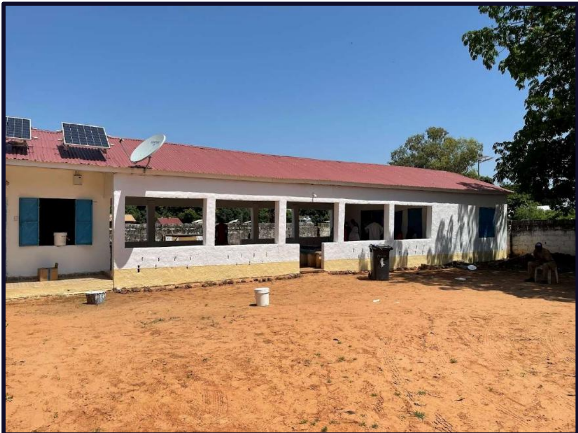
Ilustración 5. Ampliación y mejora de sala de espera y anexos.
