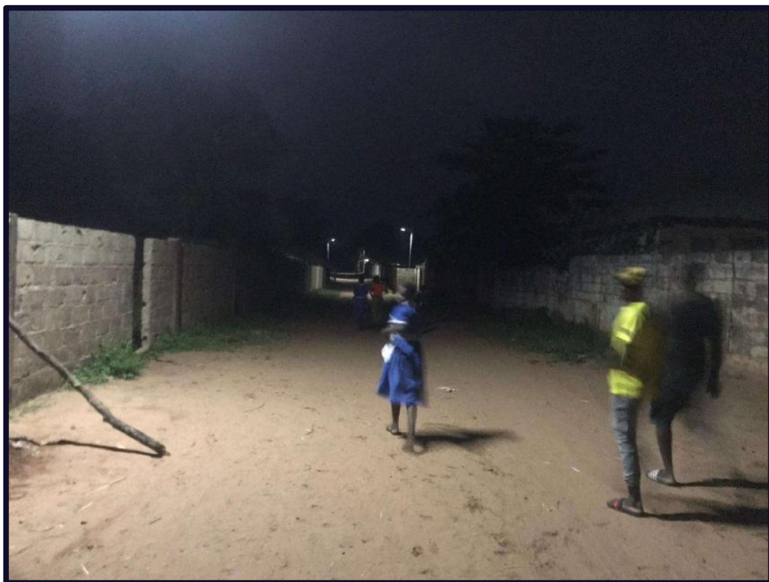
Ilustración 10. Vista de una calle de Jarra Sukuta con las farolas instaladas.
