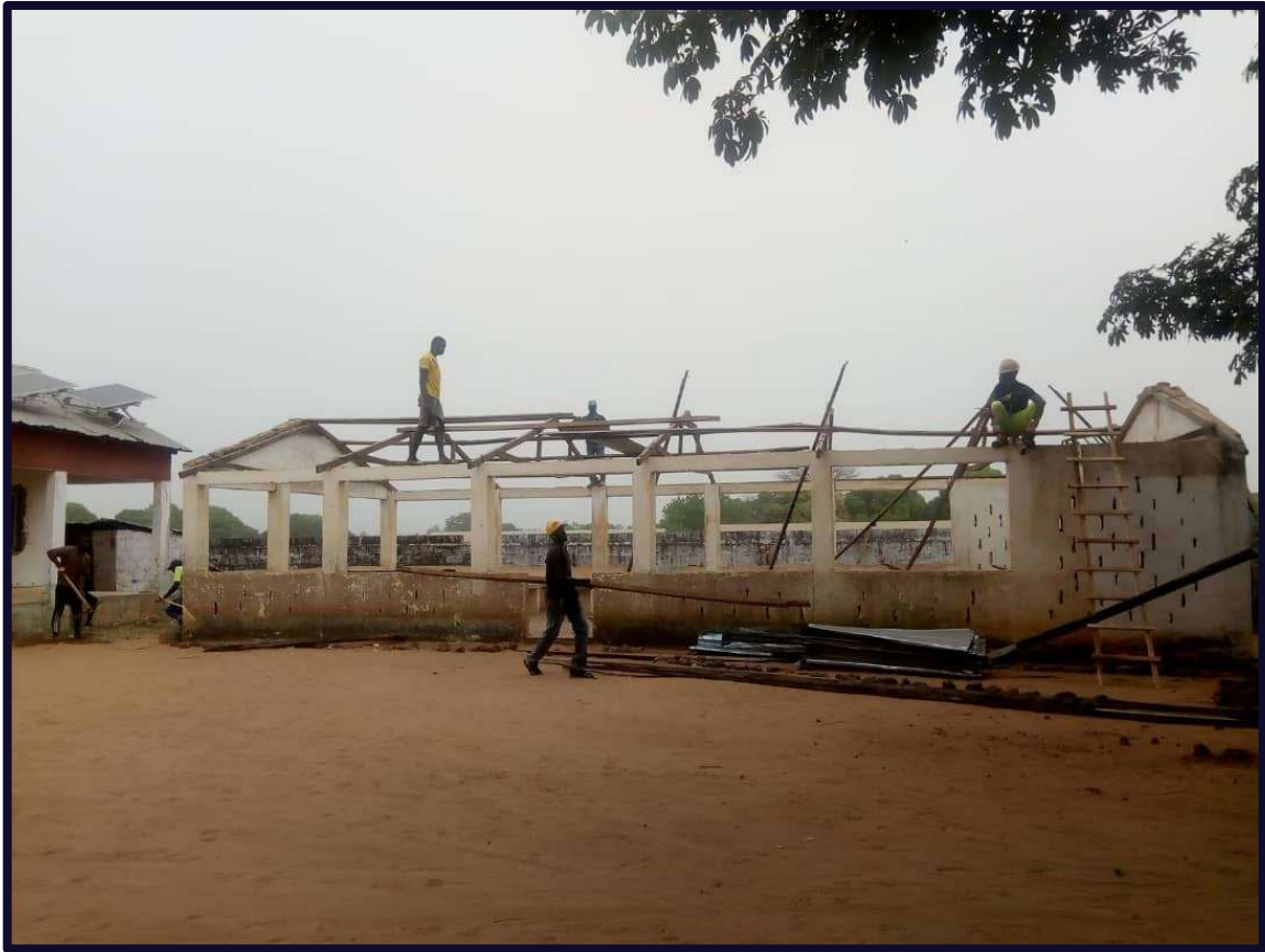
Ilustración 4. Reforma de la sala de espera.
